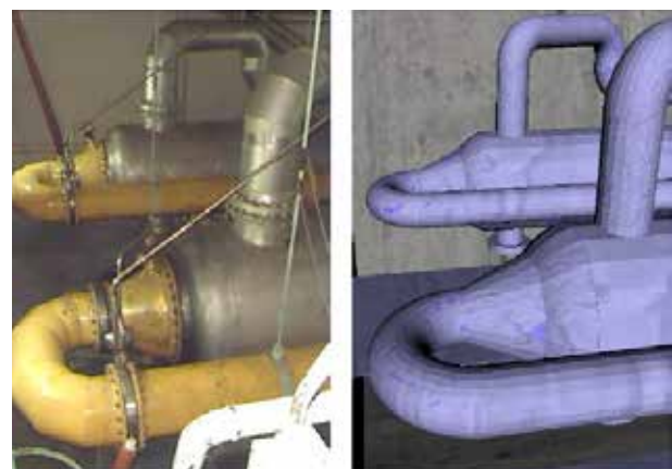
Fot. 2. Po lewej – zdjęcie rzeczywistej instalacji w elektrowni jądrowej, po prawej – ta sama instalacja odwzorowana w postaci modeli w programie Visiplan (źródło: materiały SCK-CEN [2])
