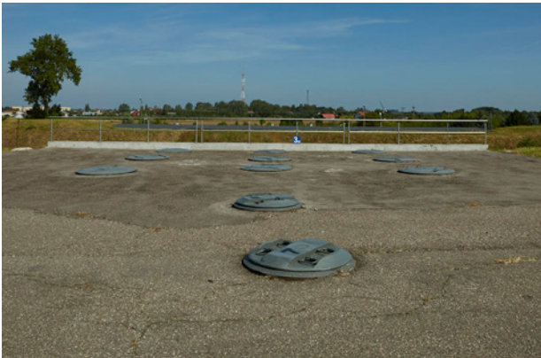
Fot. 4. Komory obiektu numer 3a
