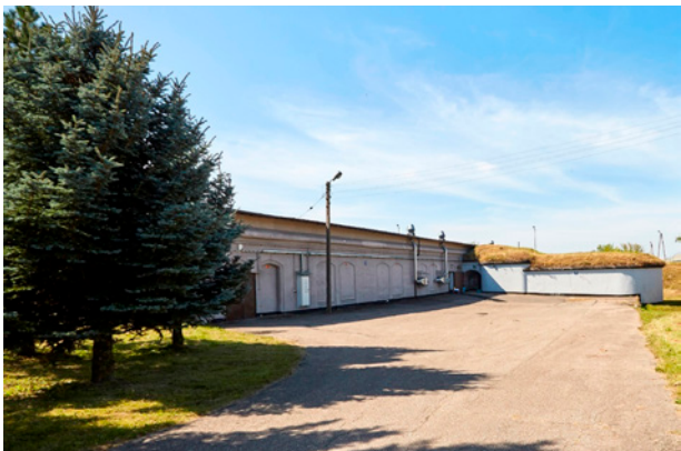
Fot. 2. Obiekt nr 1 w KSOP w Różanie
