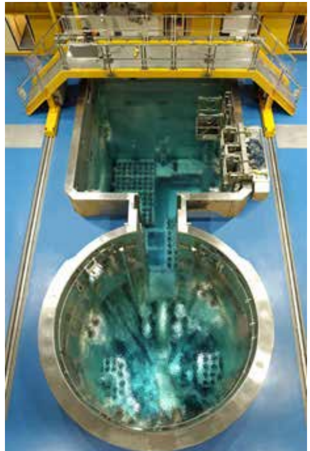
Fot. 2. Basen reaktora OPAL. Wykonany ze stali nierdzewnej i 4,5 m szerokości, zawiera wodę demineralizowaną, używaną do osłony i chłodzenia Photo 2. The OPAL reactor pools. Made of stainless steel and 4.5-metre (15 ft) wide, it contains demineralised water used for shielding and cooling
