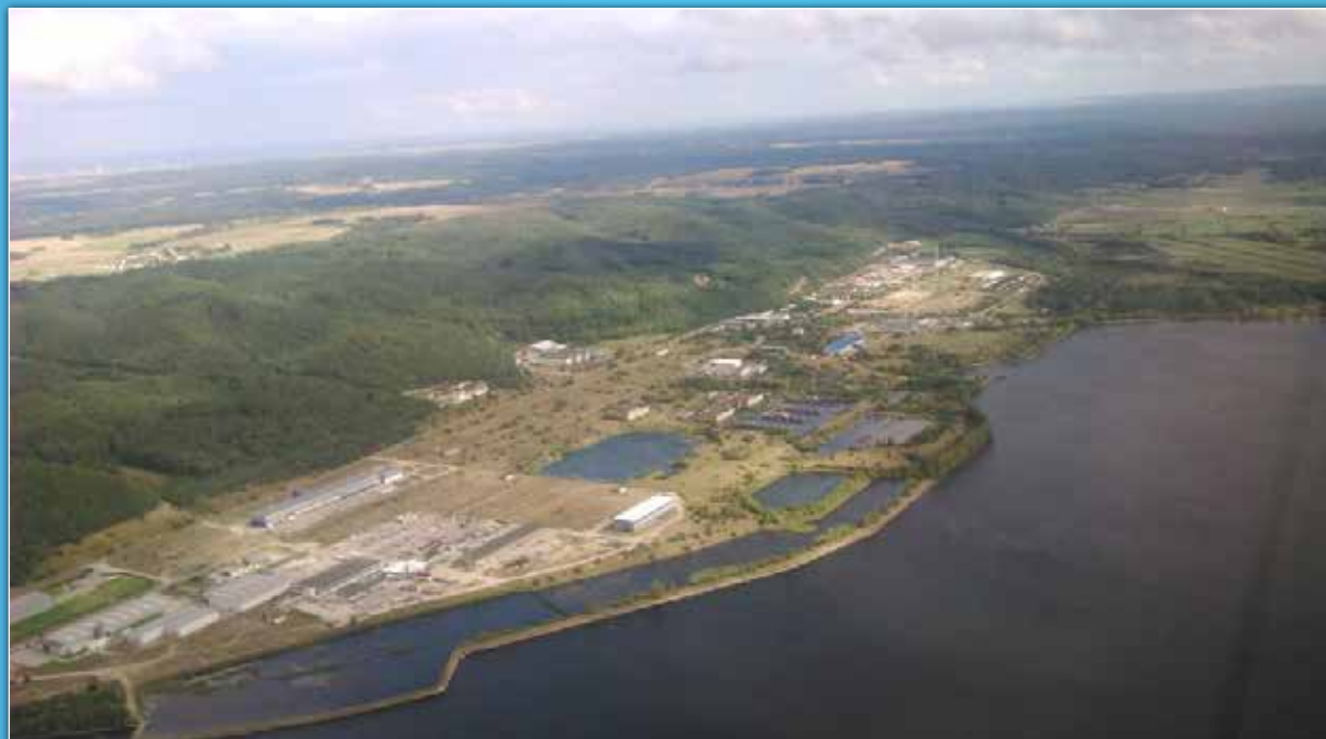
Widok z góry na teren porzuconej budowy EJ "Żarnowiec"
