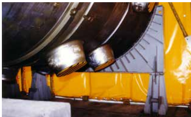
Fot. 4. Zbiornik ciśnieniowy reaktora 1-bloku magazynowany w tymczasowym namiocie na placu budowy EJ „Żarnowiec” (fot. W. Kielbasa)
