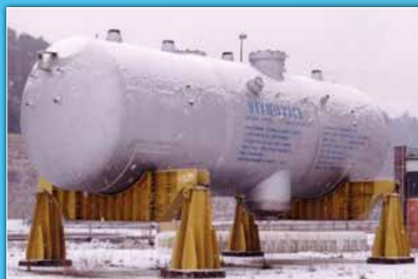
Wytwornica pary składowana tymczasowo na terenie budowy EJ "Żarnowiec"
