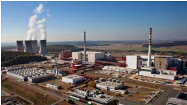
Fot. 2. Widok na EJ Mochovce (Słowacja)
