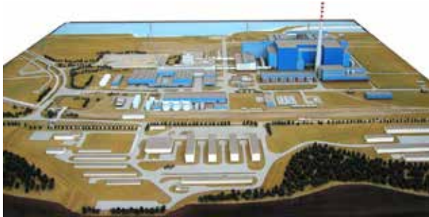
Fot. 4. Makietę I etapu EJ „Żarnowiec” Photo 4. Mock-up of the Żarnowiec NPP
