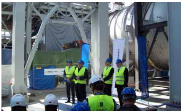
Fot. 1. Minister Krzysztof Tchórzewski w towarzystwie przedstawicieli wykonawców inwestycji na tle fragmentów nowego bloku energetycznego (fot. Wojciech Głuszewski)
