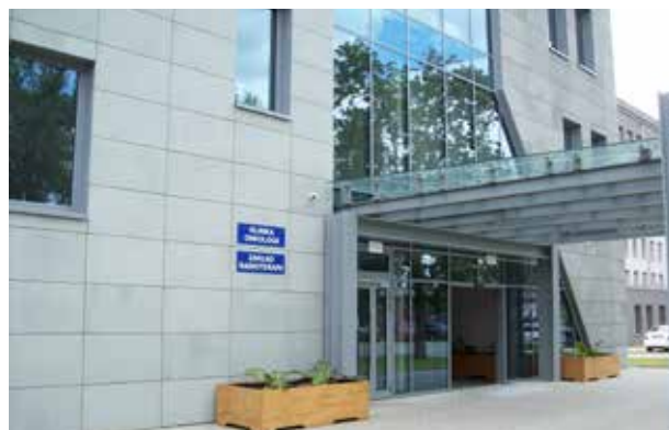
Fot.1. Budynek Nowego Zakładu Radioterapii
