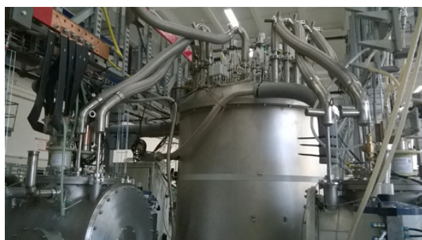
Fot. 6. Hala montażu elementów systemu NICA – wspomagająca skraplarka – element usprawniający system chłodzenia nadprzewodnikowych elektromagnesów
