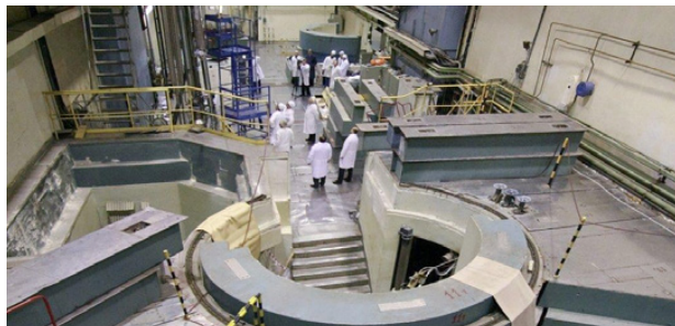
Fot. 6. Reaktor impulsowy prędkich neutronów IBR-2M zbudowany w 1964 r. pod kierownictwem D. Błochincewa i I. Franka. Podstawowe narzędzie badawcze Laboratorium Fizyki Neutronowej, w którym pracuje najlichniesza grupa polskich pracowników
