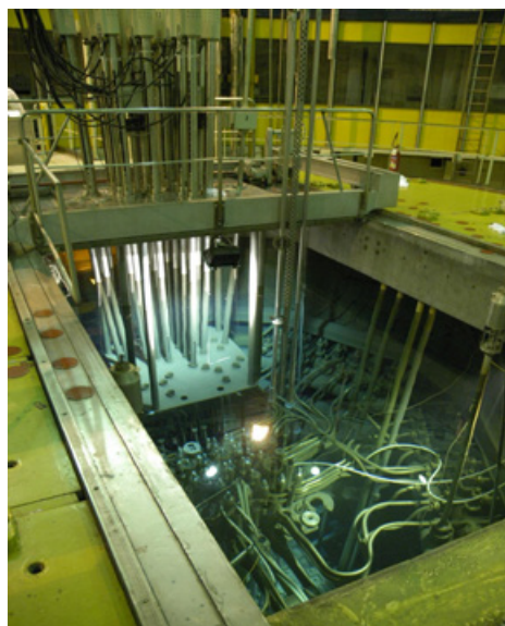
Fot. 1. Widok basenu reaktora MARIA
