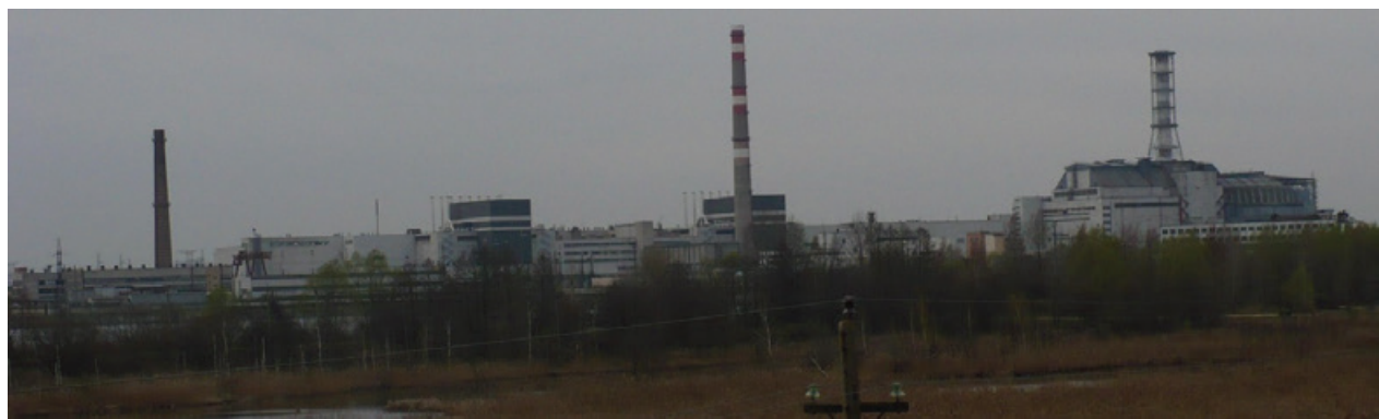
Fot. 1. Czarnobylska Elektrownia Jądrowa (2008 r.), pierwszy z prawej to sarkofag reaktora nr IV Photo 1. Chernobyl NPP (2008), first on the right: the sarcophagus of reactor no.4
