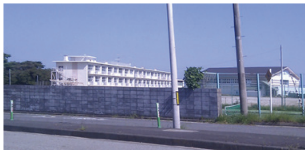
Fot. 6. Tymczasowe kontenery mieszkalne dla osób wysiedlonych z okolic elektrowni jądrowej Fukushima Photo 6. Temporary house containers for evacuees
