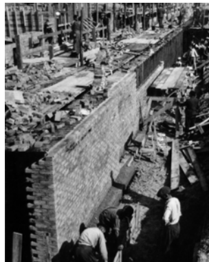
Budowa ścian budynku
