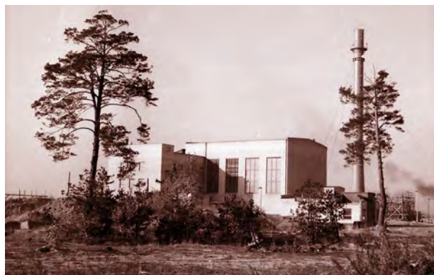
Fot. 2. Budynek reaktora EWA od tyłu
