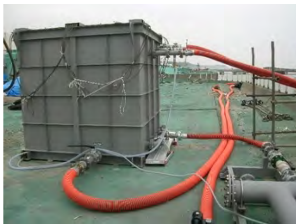
Fot. 1. Zbiornik dekontaminacyjny. Kanał wlotowy (Nuclear Engineering International www.neimagazine.com )
