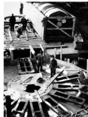
Zbrojenia pod zbiornik reaktora
