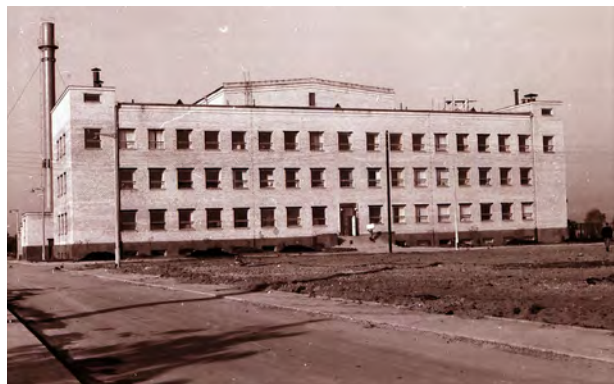
Fot. 1. Budynek reaktora EWA od frontu
