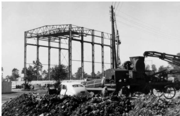
Konstrukcja hali reaktora
