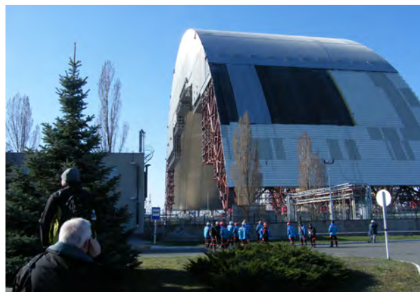
Fot. 3. Budowa nowego Sarkofagu (Arkady)
