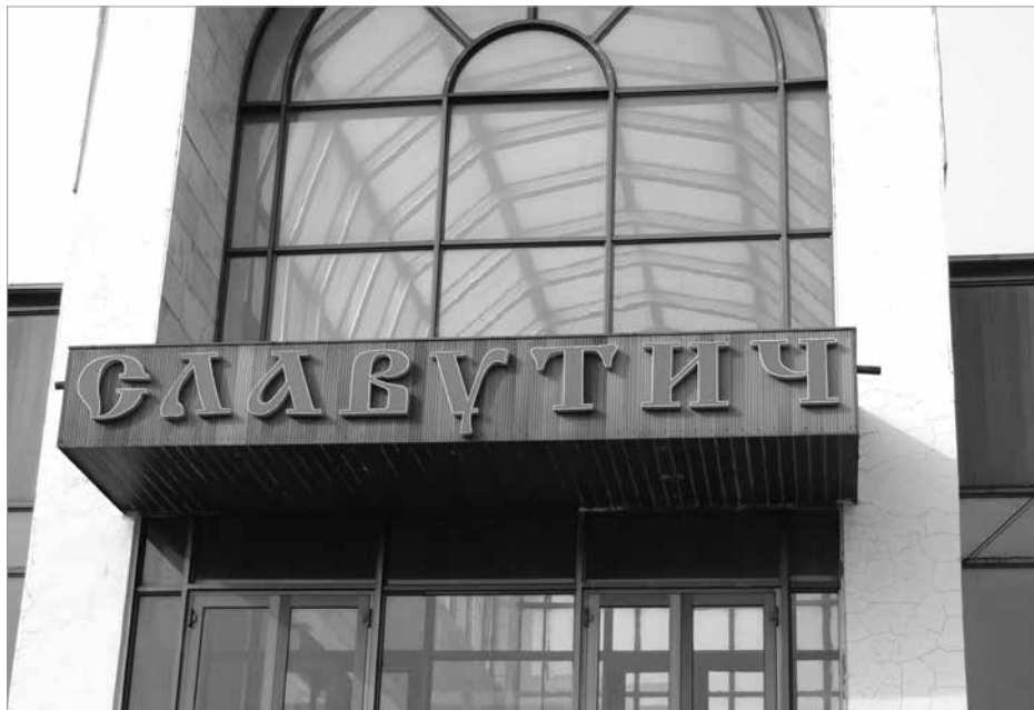
Fot.1. Dworzec kolejowy w Sławutyczu
