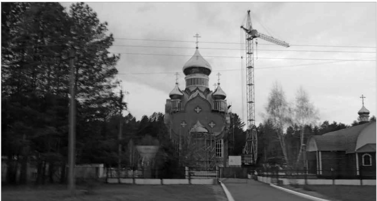
Fot.7. Cerkiew w Sławutyczu (wciąż w budowie)
