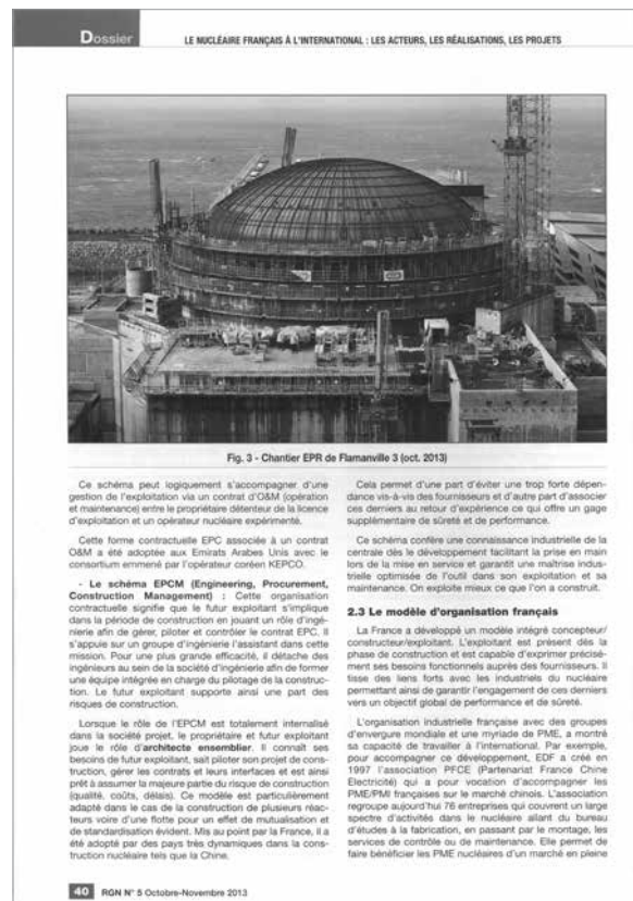
Fot.3. Budowa 3. bloku EJ Flamanville
