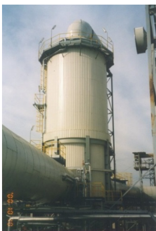
Rys. 9.16. Podstawowe urządzenia Instalacja Oczyszczania Spalin Elektrowni Pomorzany: A – wieża nawilżania spalin; B – zbiornik wody amoniakalnej; C – Instalacja gromadzenia produktu ubocznego
