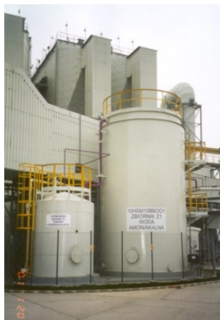
Rys. 9.16. Podstawowe urządzenia Instalacja Oczyszczania Spalin Elektrowni Pomorzany: A – wieża nawilżania spalin; B – zbiornik wody amoniakalnej; C – Instalacja gromadzenia produktu ubocznego
