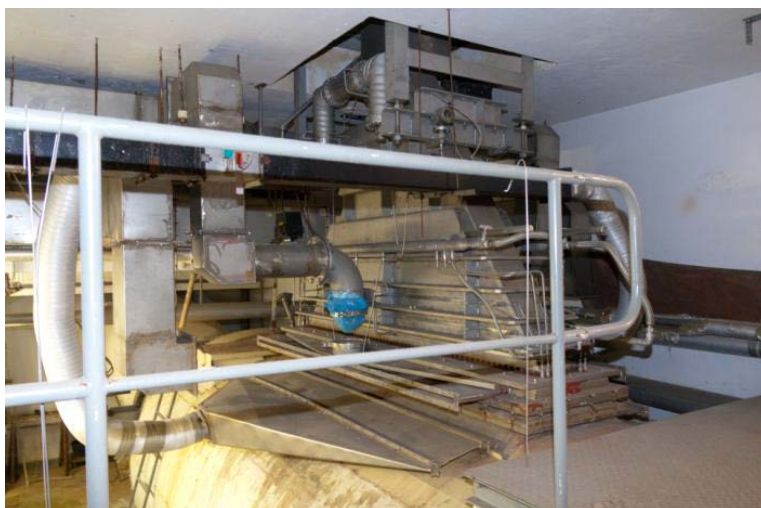
Rys. 4.15. Akcelerator służący do oczyszczania spalin
