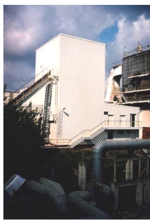
Rys. 9.16. Podstawowe urządzenia Instalacja Oczyszczania Spalin Elektrowni Pomorzany: A – wieża nawilżania spalin; B – zbiornik wody amoniakalnej; C – Instalacja gromadzenia produktu ubocznego
