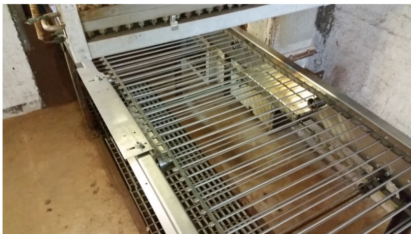
Rys. 15. Widok dodatkowych osłon chroniących ceowniki przed wiązką promieniowania.
